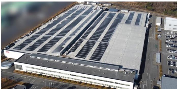
(株)日ピス岩手一関工場 メガソーラーシステム
