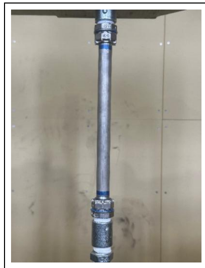
写真 4-19-2 内圧繰り返し試験後の引抜試験状態
