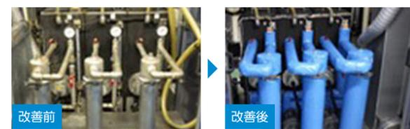
工場内の洗浄機におけるフィルターと配管部をグラスウールで保温することで、洗浄機配管からの循環温水の放熱を抑制しました。この対策を同型設備に順次展開することで、合計で約30トンのCO<sub>2</sub>を削減しました。
