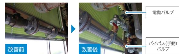
工場建屋入口配管に電動バルブを取付け、スケジュールタイマーでコントロールし、休日にエア共有を停止することで、コンプレッサーの年間電気使用量は7,960kWh、年間CO<sub>2</sub>排出量は44トン削減しました。
